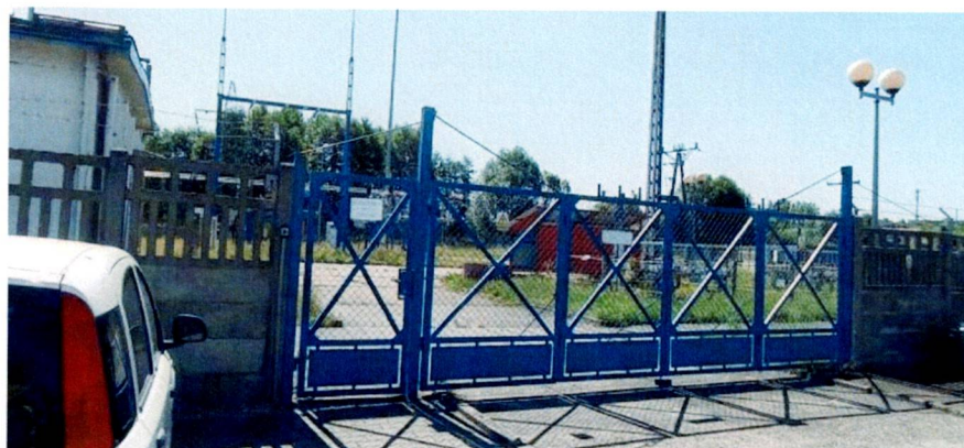
Otoczenie stacji 110/15 kV Przedbórz – widok od strony bramy wjazdowej
