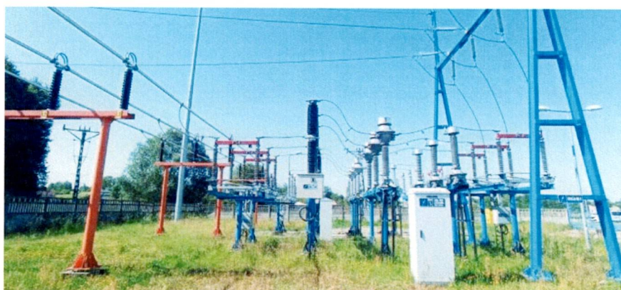
Rozdzielnia napowietrzna 110 kV – pole rozdzielcze linii Szreniawa
