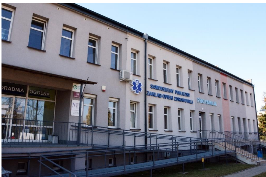
Front Budynku Samodzielnego Publicznego Zakładu Opieki Zdrowotnej PRO FAMILIA w Radomsku
