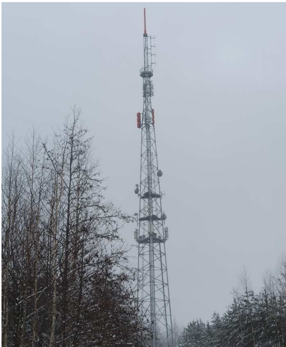
Zdjęcie 1 Badany obiekt
