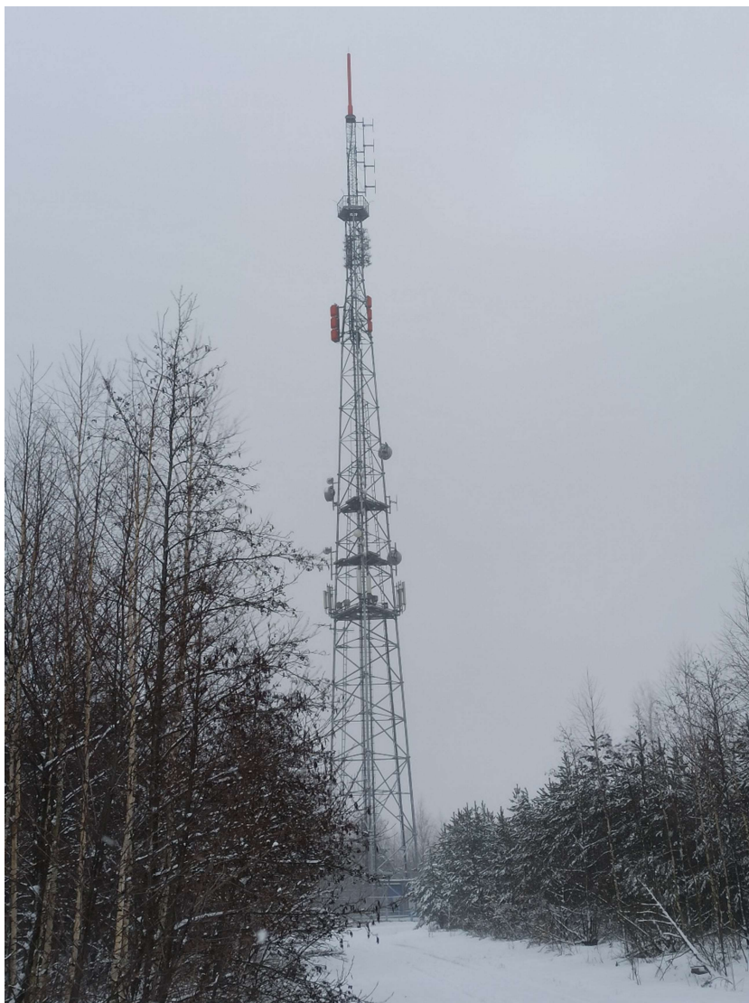
Zdjęcie 1 Badany obiekt
