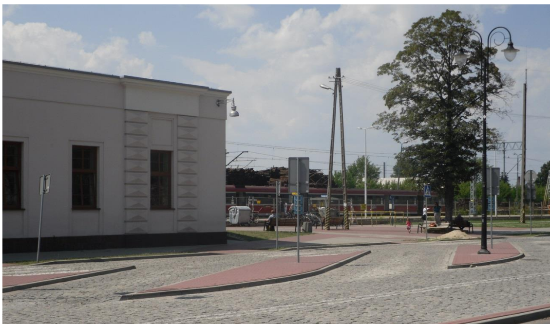
Zdjęcie 3. Stanowiska autobusowe i peron kolejowy (widoczny pociąg) na węźle przesiadkowym w Radomsku (fot. Refunda sp. z o.o. )
