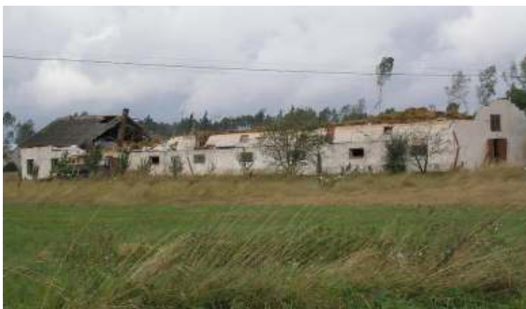
Rysunek 70. Efekty przejścia trąby powietrznej przez teren powiatu radomszczańskiego w sierpniu 2008 r. (źródło: http://www.wiadomosci24.pl , foto: Tomasz Mazur)
